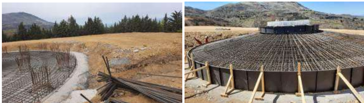
Слика 27 Армирачки работи на темел за ветерна турбина (Извор: Т. Митев)
