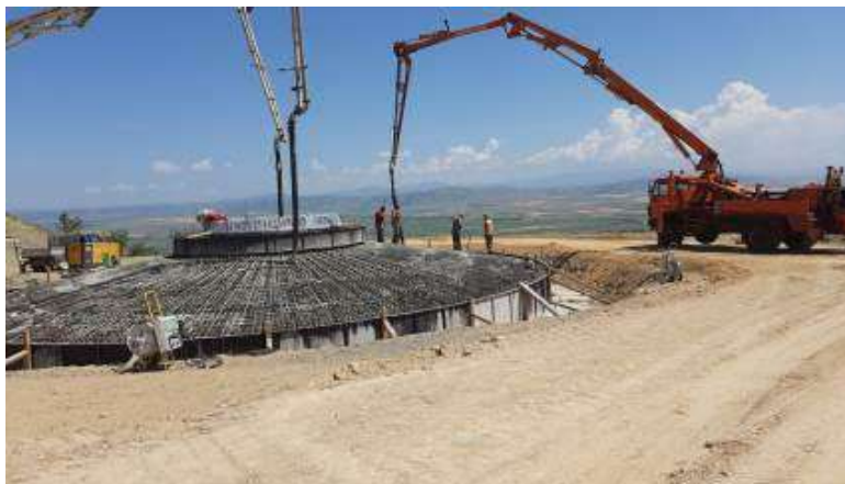
Слика 26 Бетонирање на темел за ветерна турбина (Извор: Т. Митев)
