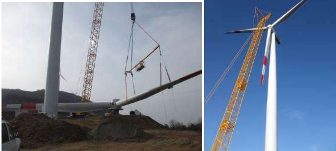
Слика 28 Примери на инсталација на делови од ветерни турбини (Извор: Т. Митев, Google)
