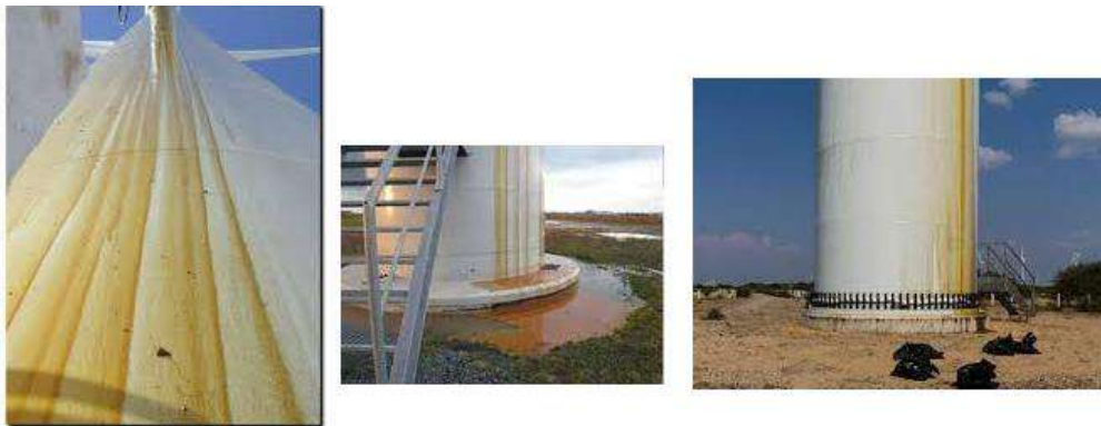
Слика 156 Истекувања на масло од ветерна турбина
