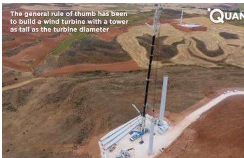
Слика 24 Монтажа на носечки столб и внатрешност на столб на ветерната турбина (Извор: Google)
