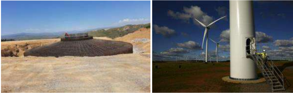
Слика 20 Изглед на темел во фаза на градба и по завршување на градба (Извор: Google)
